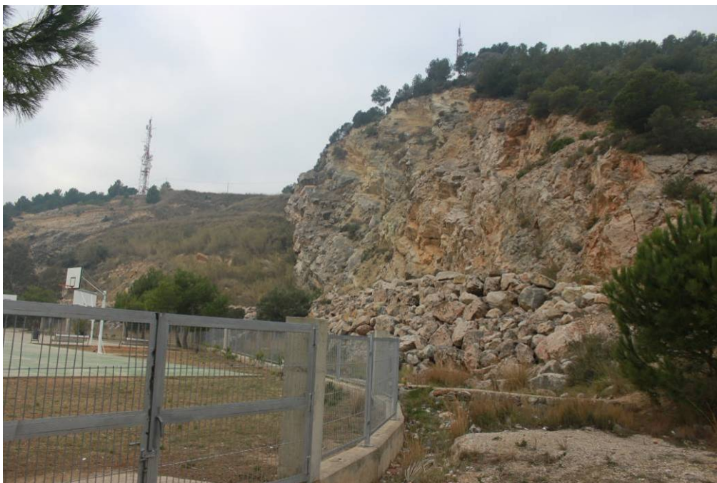
Fotografia 6. Talús de l'antiga pedrera de la Torreta des de l'extrem nord del centre escolar. A la base el dic d'escullera.
