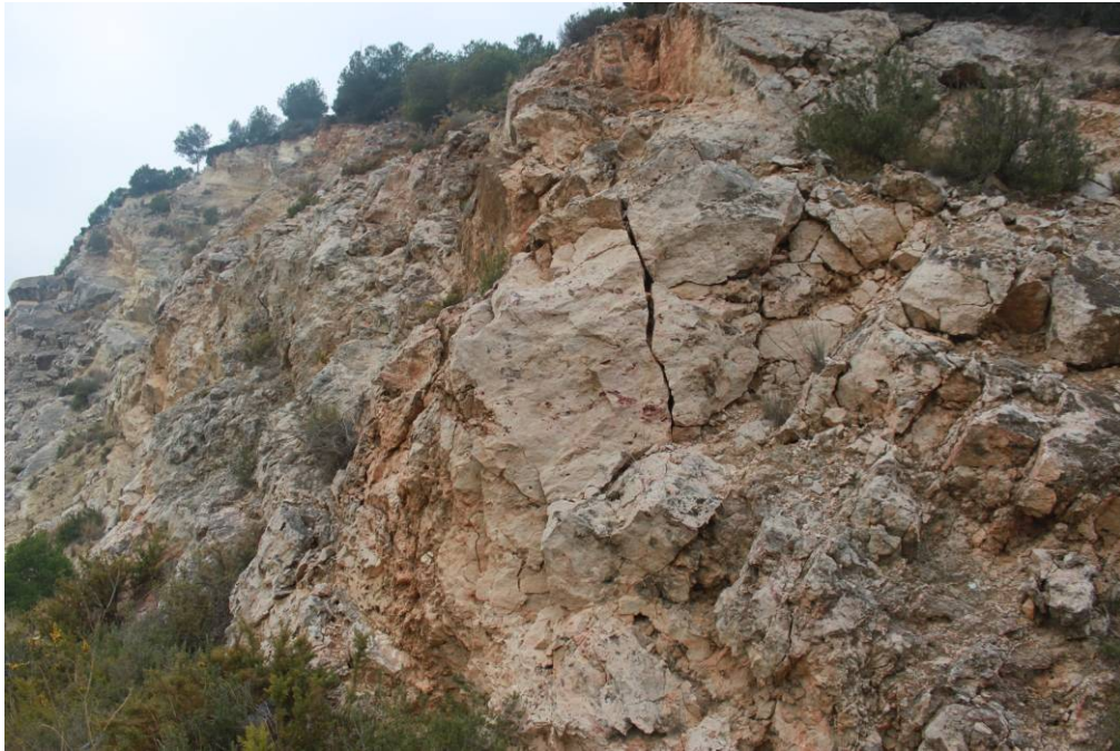
Fotografia 9. Volum parcialment individualitzat en el sector nord del talús.
