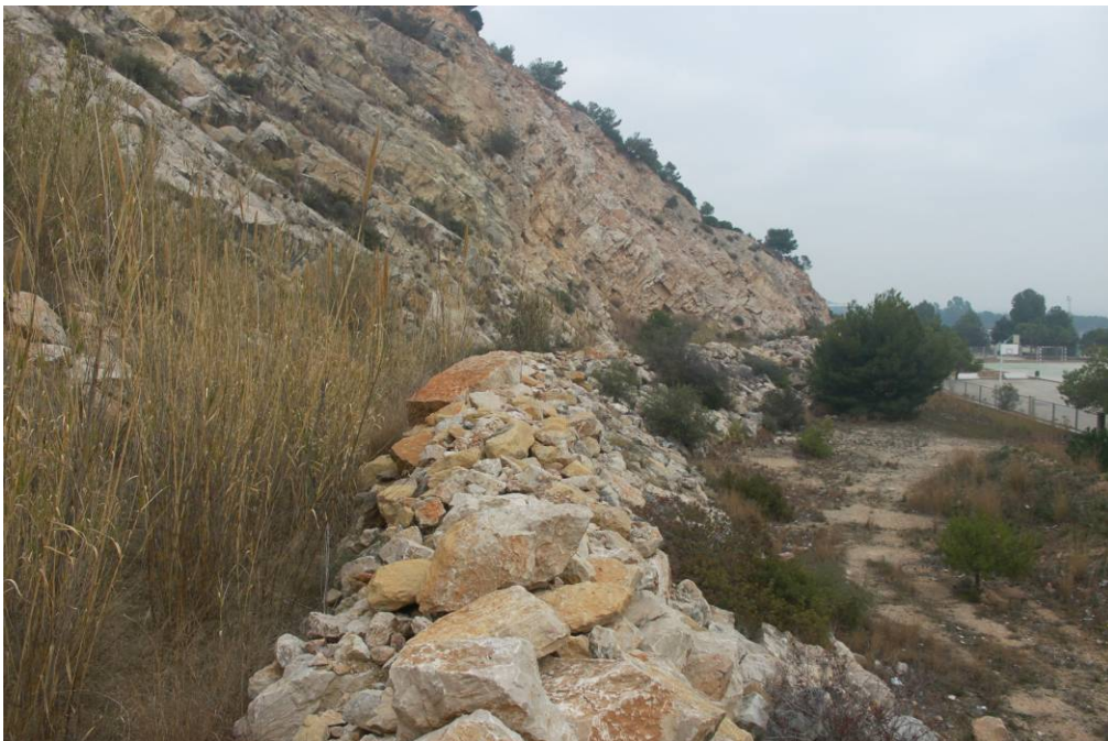
Fotografia 8. Dic d'escullera a la base del talús.
